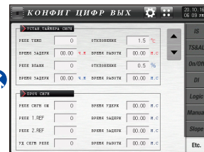
[Рис. 11-11] Экран №3 настройки реле дополнительного выхода
